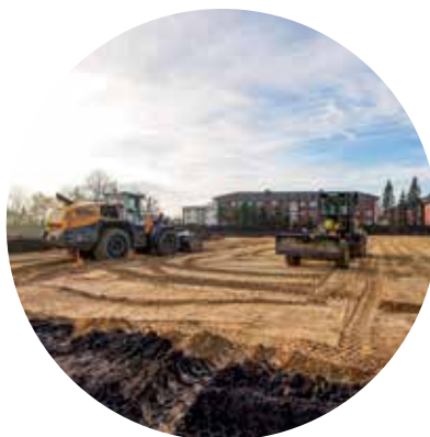
Die neue Ansicht der Pestalozzistraße 49/51
